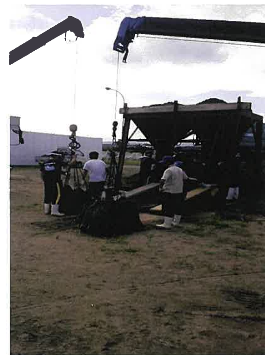
3経営体による土俵詰め作業風景
